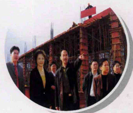
市领导刘日知、李嘉、陈小山、翁永卫等深入新校区和培训中心建筑工地检查工程质量
