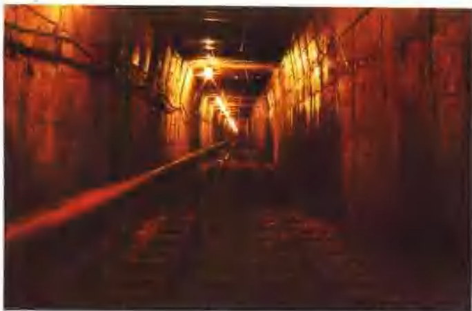
采矿运输坑道
