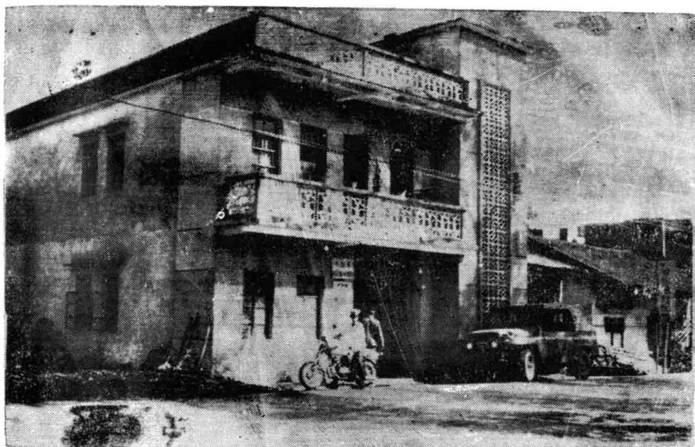
东石交通中心管理站
