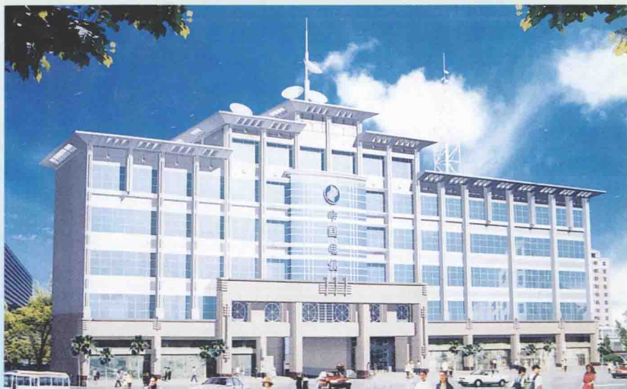
▲ 建设中的广场路电信综合营业楼
