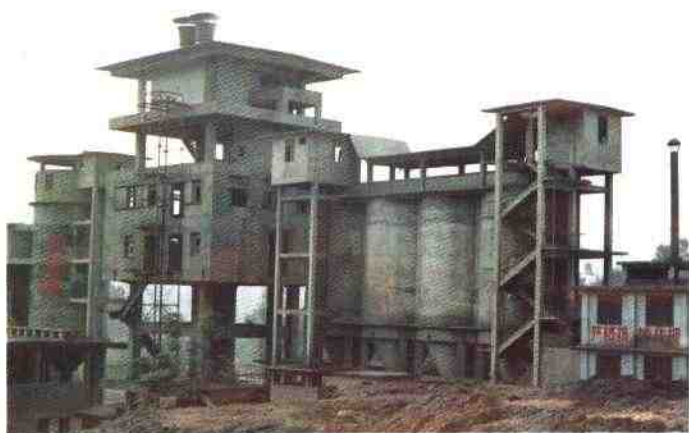
和平水泥厂 上图是月产5000吨水泥的新生产线。
