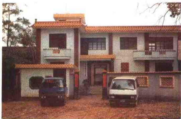
和平 106 厂办公大楼 该厂主要生产烟花、爆竹系列。
