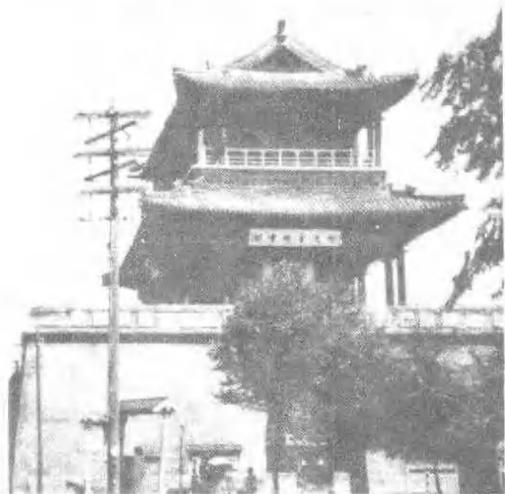
绥远城钟鼓楼（1959年春季拆除前拍摄）
