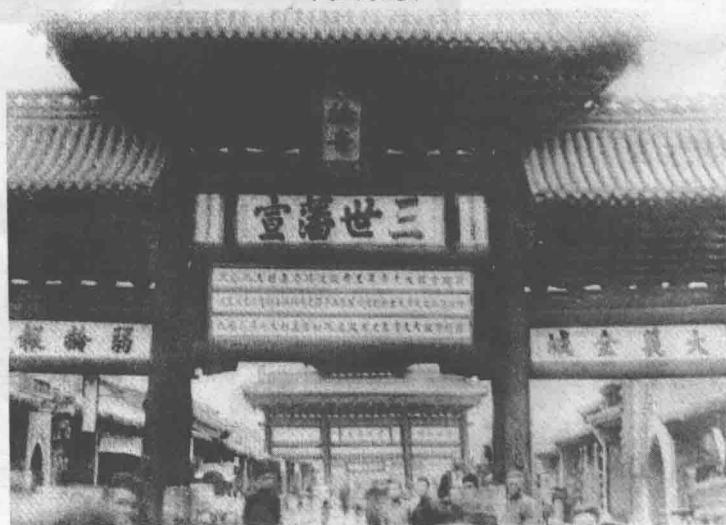
古州城廓、牌坊一组
