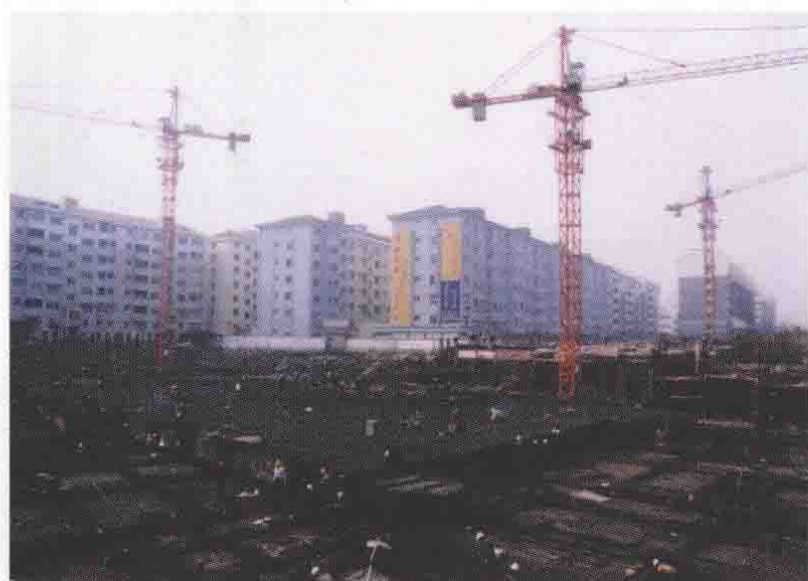
正在建设中的“忆江南”
