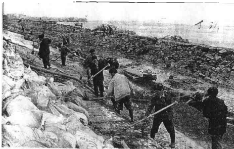
浦东国际机场二期围海造地工程启动。图为三航公司工人在七标工地抛石筑堤。本报记者 吴文强摄。
