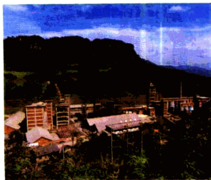
该公司水泥厂
