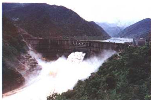
二滩电站大坝
