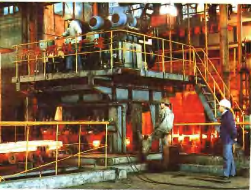
1986年4月1日，由我厂自己设计、制作、施工安装的转炉炼钢配套项目——小方坯连铸机工程建成投产。
