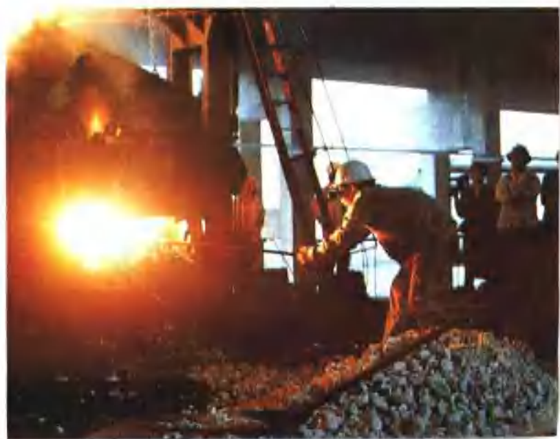
1987年5月1日，我厂5吨电炉大修改造工程胜利竣工投产。
