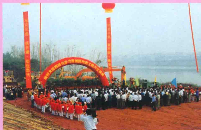
梅州大堤西堤加固改造工程开工典礼(罗小丰摄)
