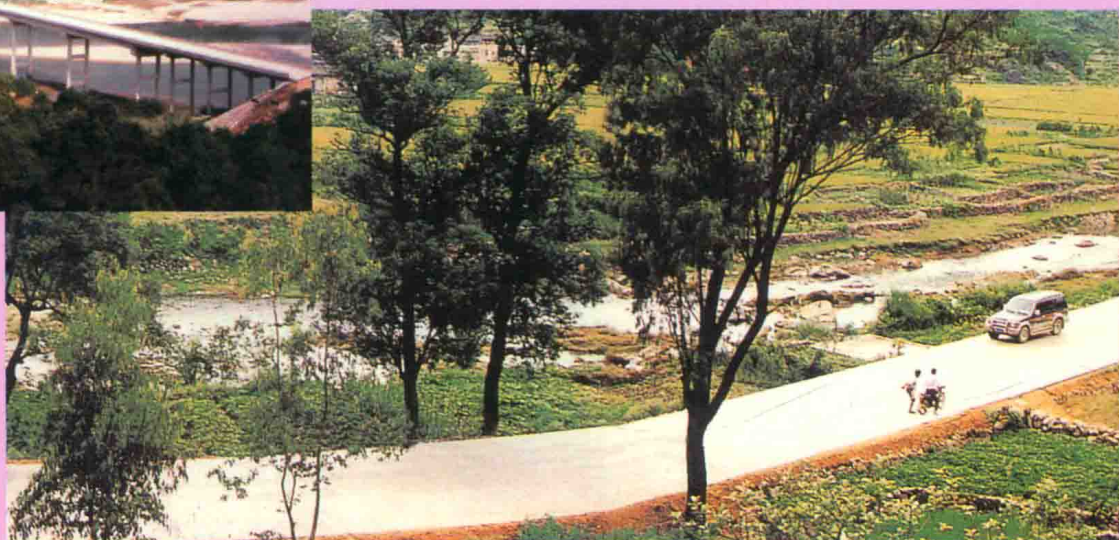
206国道梅南至北斗段80公里改造竣工通车
