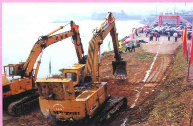
梅州大堤北堤改造工程开工挖土(罗小丰摄)
