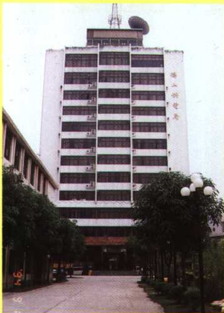
▲ 鶴山市供電局電力調度中心大樓
