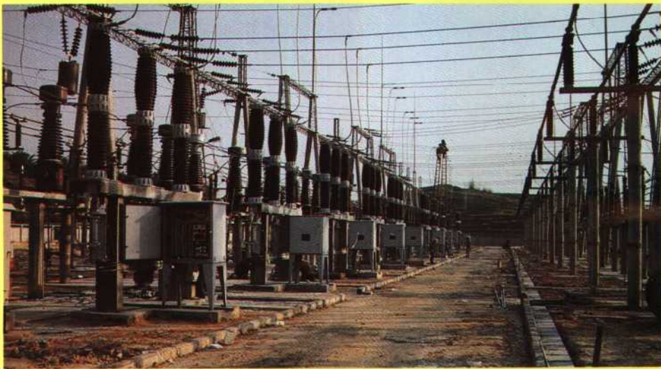
▲ 正在興建中的220KV鶴山變電站
