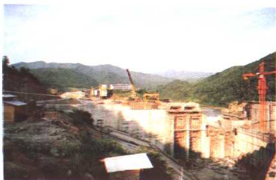
← 中国建设银行尤溪县支行提供 1.68 亿元固定资产贷款, 1997 年安排放贷 7000 万元支持雍口电站建设。图为雍口电站建设工地。
