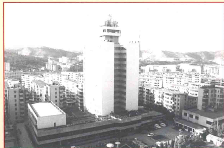
原十堰供电局办公、调度大楼
