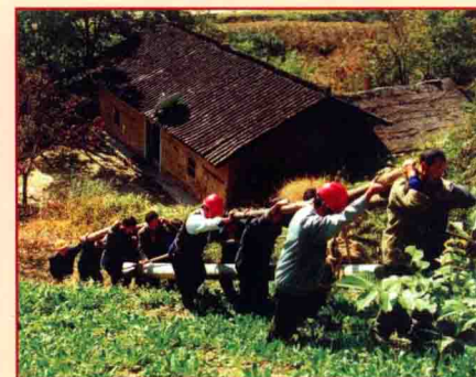
1999年，农网改造施工现场
