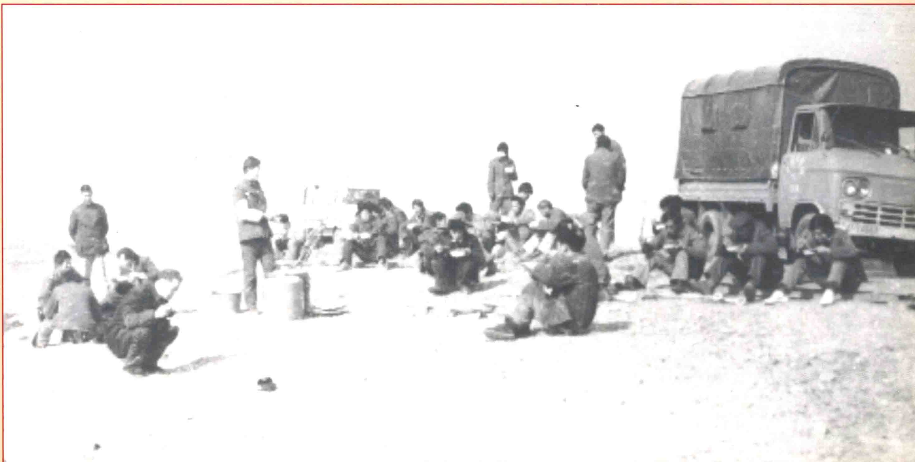
1976年11月，原郧阳地区电力局输电分局职工在黄竹线施工工地
