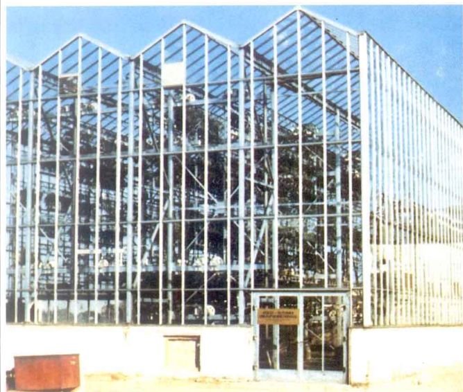
立体回転移動方式によるタワー型野菜工場。太陽光を利用する栽培法で、チェーンコンベアで周期的に上下に移動させる。(オーストリア)
