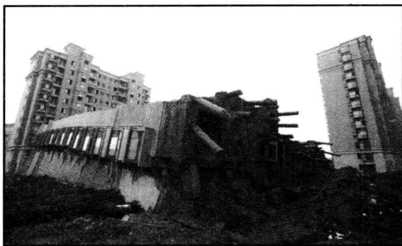
图 1.3 上海市“莲花湖景河畔”倒塌现场
