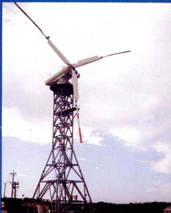
風力発電 風車の直径30mで出力300kw (沖永良部島) 写真/九州電力
