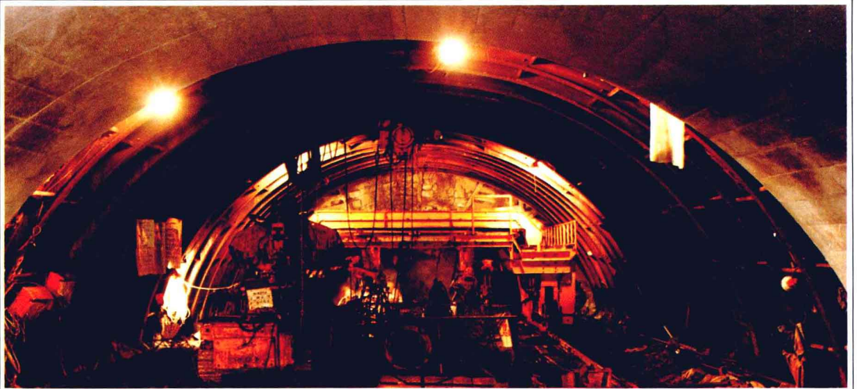
本坑上部の半断面全景。最深部では、この上を約100mの厚さの岩石と140mの深さの海水がおおっている
