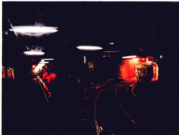
本州側竜飛工区の作業坑と本坑とを結ぶ第10連絡横坑
