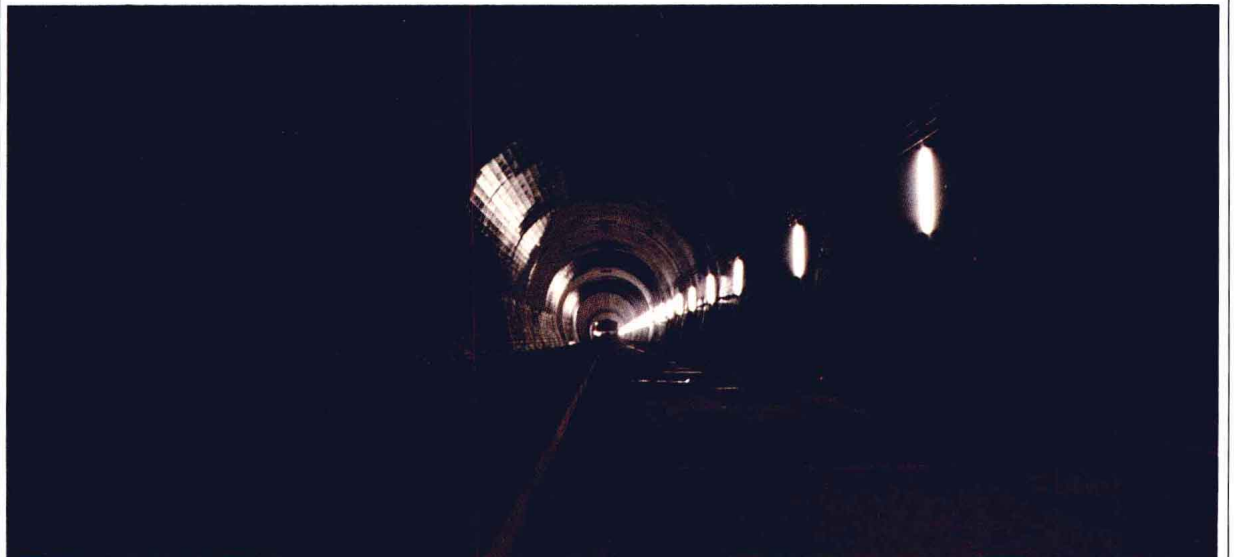
海底部の完成区間。当初目標とされていた新幹線はしばらく見送られ、津軽海峡線(中小国～木古内間)で在来線と接続する
