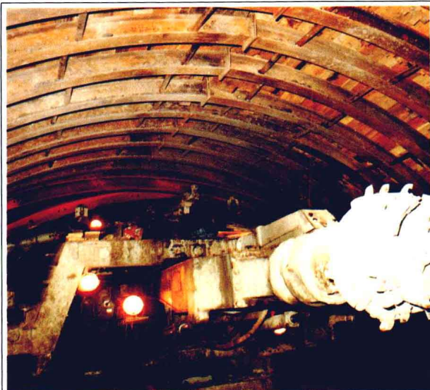
ロードヘッダーなどの大型機械を導入して掘り進められた
