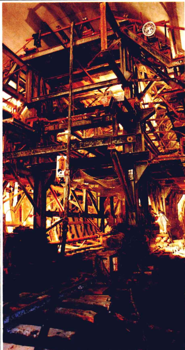
全断面セントラル。コンクリートを打つために型枠を組み立てる
