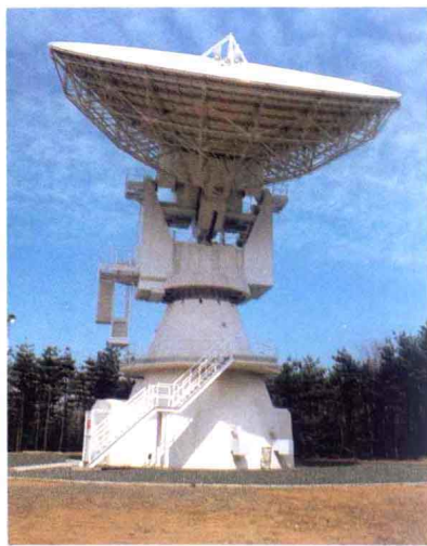
気象衛星通信所の直径18mのアンテナ
