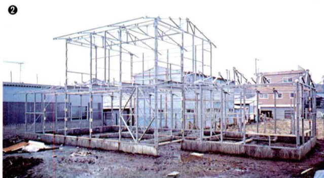
①基礎 鉄筋で補強されたコンクリート造の布基礎と、補強コンクリートブロック造の間仕切り基礎で構成 ②架構体 軽鉄系の鋼材で架構 ③外装 外装パネルと屋根を取りつける（鉄骨とパネルの接合部にテープ状の断熱シートで断熱）④内装 床が張られ、間仕切り枠が組みこまれる ⑤完成 外部をアルミ・スチール・石綿材などで構成し防火上の配慮をする（約1か月半）
