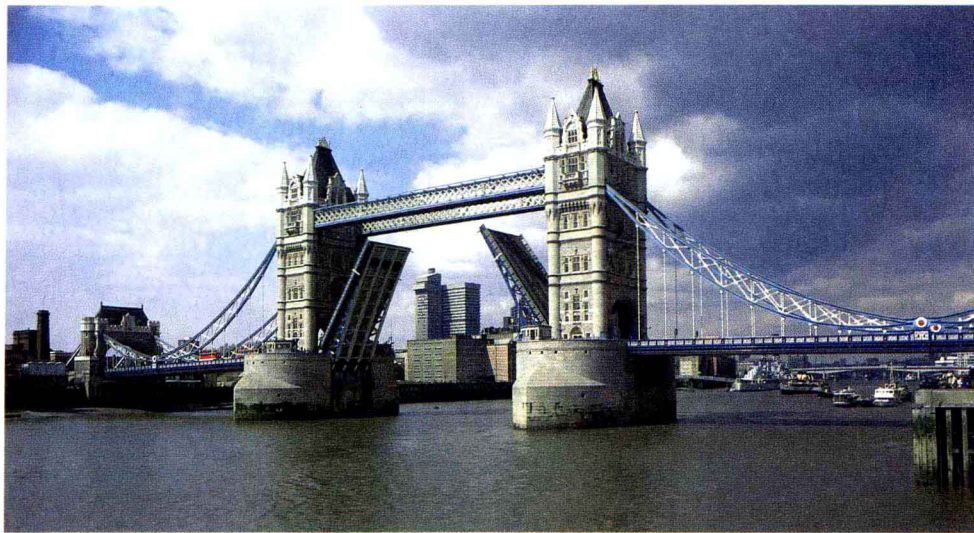
タワー・ブリッジ 重量1000tの可動部分の橋桁は、水力によって約90秒で全開する。 塔内には、橋桁開閉のメカニズムを示す展示館もある
