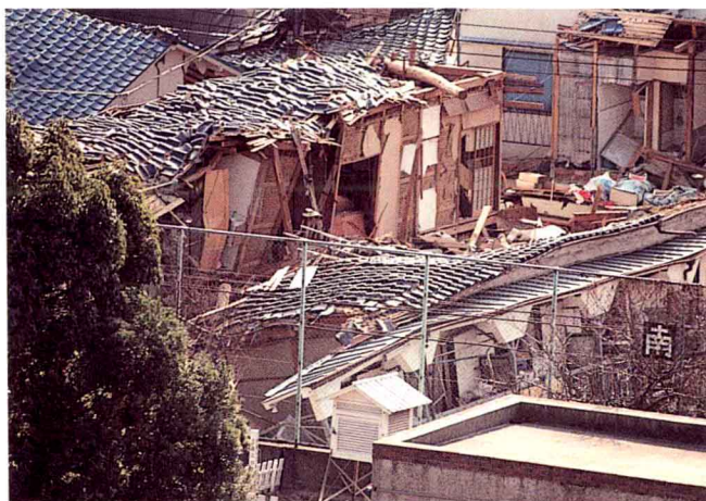
福池小学校南側アパート
