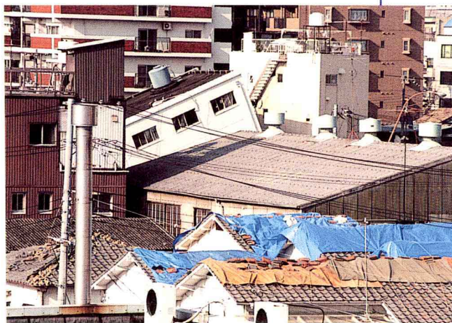
本山南町・1階が壊れ傾く住宅。
