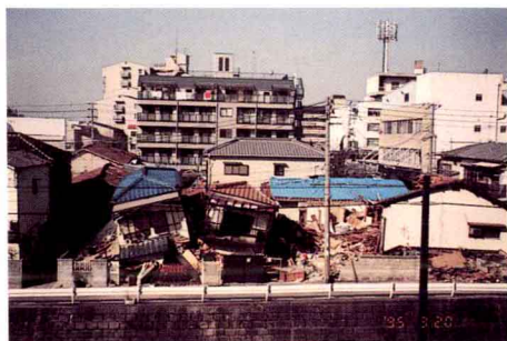
マンション前の民家1階部分が壊れている
