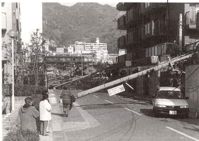
本山南町9丁目。電柱が西側から東側に倒れている。 断層が走った方向なのか？
