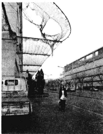
廊坊富士康园区，宿舍楼外墙包裹着一张大网
