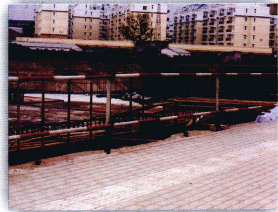
基坑临边防护
