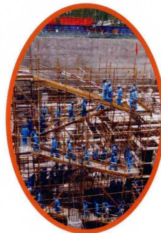
基坑上下通道
