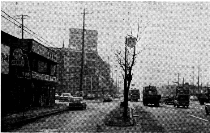
西区水道道付近（中央が神奈川日産ビル）
