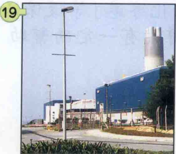
龍鼓灘發電廠利用天然氣發電
