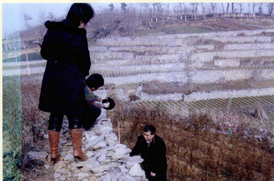
◀ 审计人员现 场勘验以工代赈 坡改梯工程。
