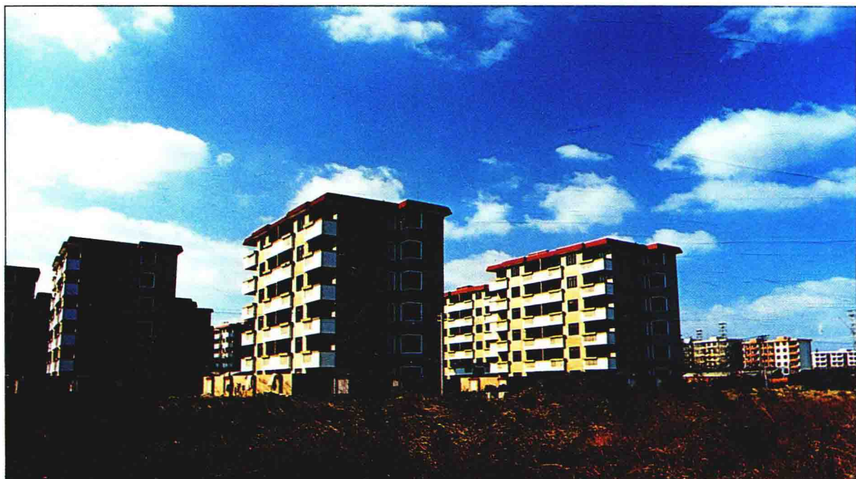
正在施工建设中的迎园新邨住宅区
