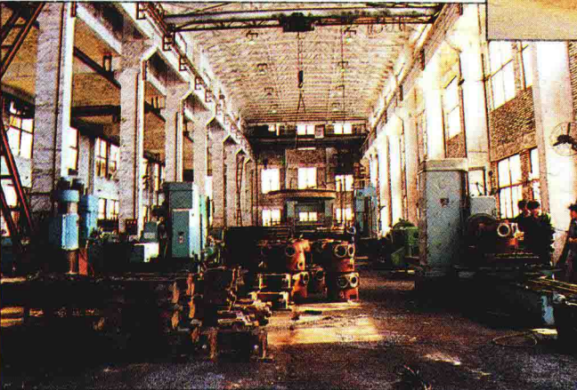
化机厂金工车间一角
