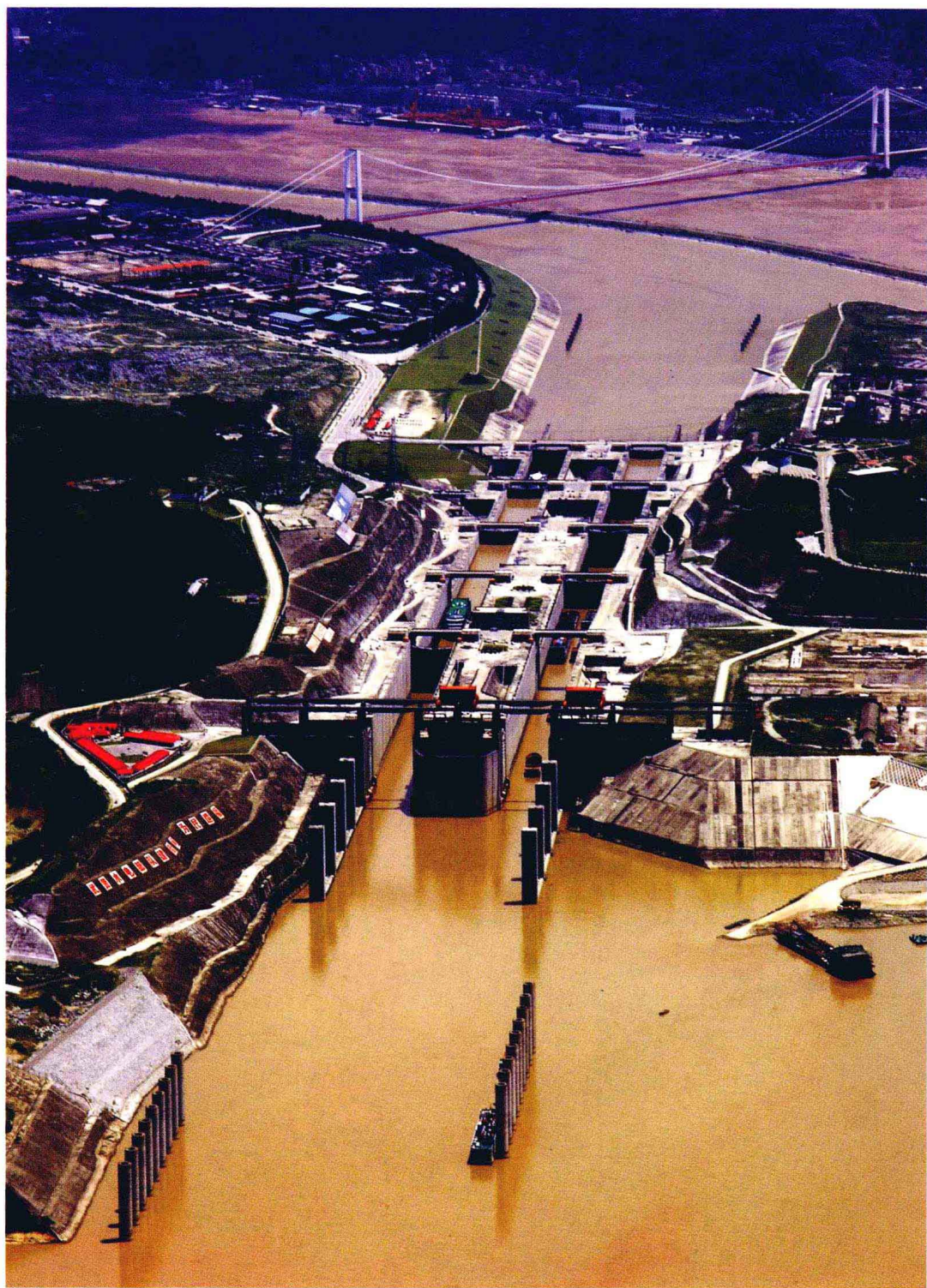
三峡工程五级船闸
