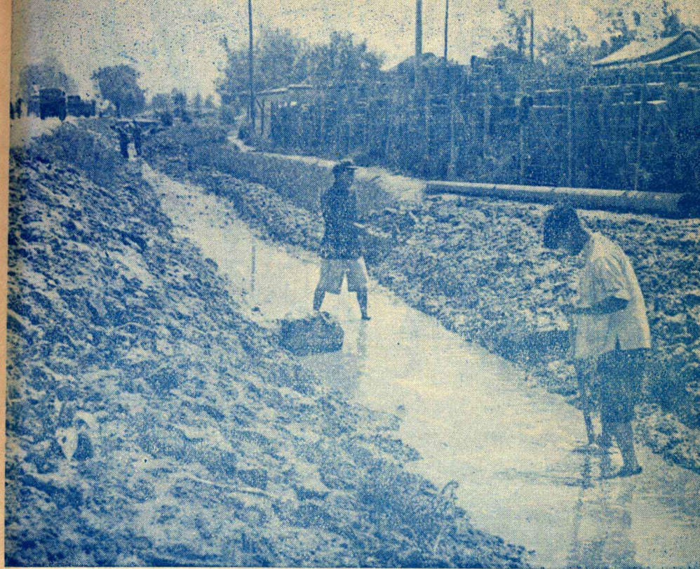
8.養路工人發現邊溝排水不暢，修挖邊溝。
