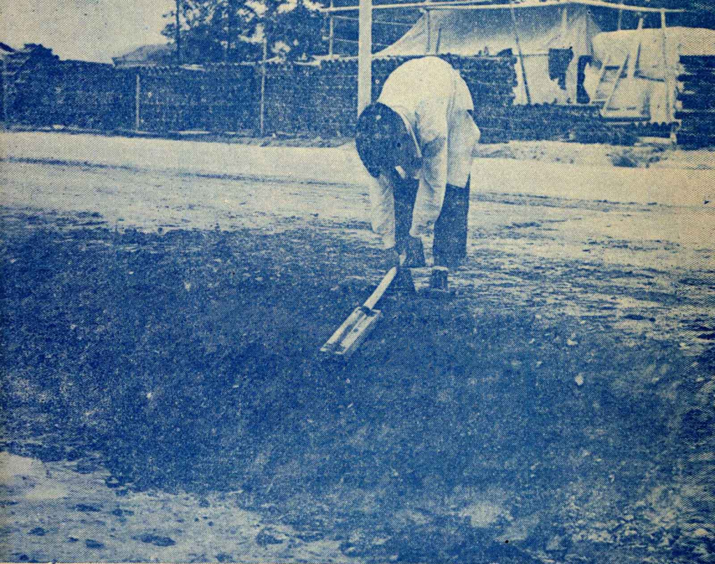
6.道班工人用自已創造的夯實板拍實邊坡。
