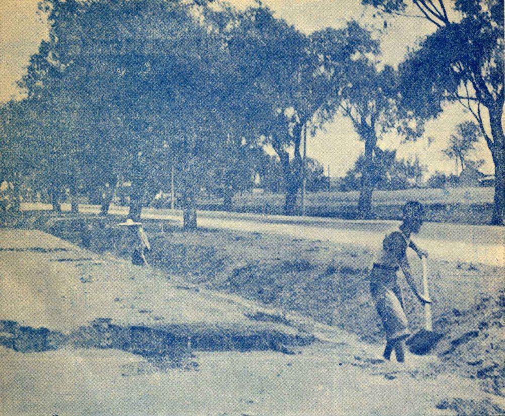
5. 雨後道路被雨水冲毀，養路工人發現後立即修復。
