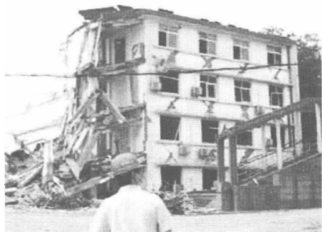
(b) 未加固的办公楼震后局部倒塌
