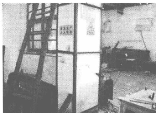
图 1-11 单层砖柱厂房采用外包型钢加固，砖柱裂而不倒
