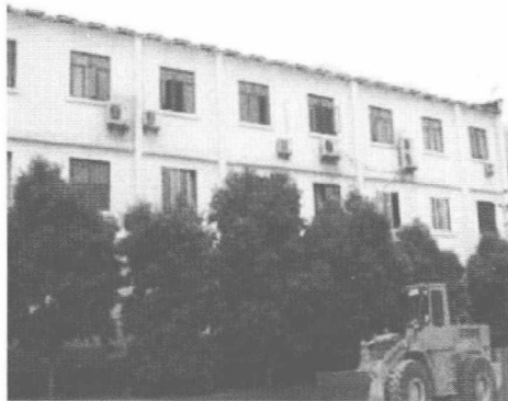
(a) 加固的办公楼震后完好无损
