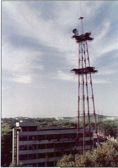
南京热电厂微波通信塔
