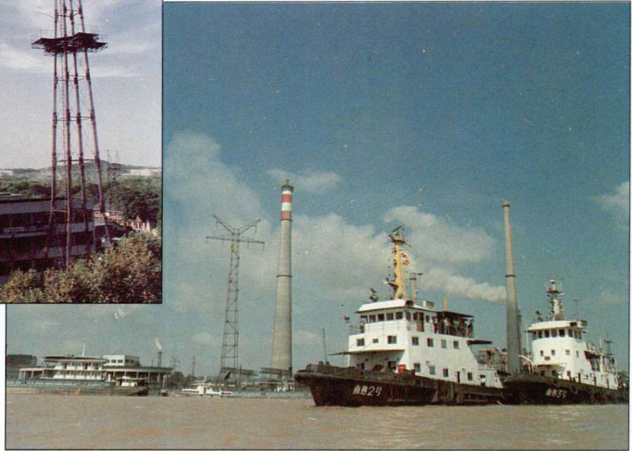
江苏省第一家热电厂——南京热电厂
