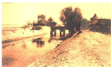
图1-12 汉武帝时在宁夏修建的汉渠遗址
