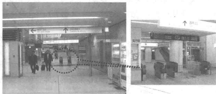
图 1-3 东京地铁车站常开式双向闸机
