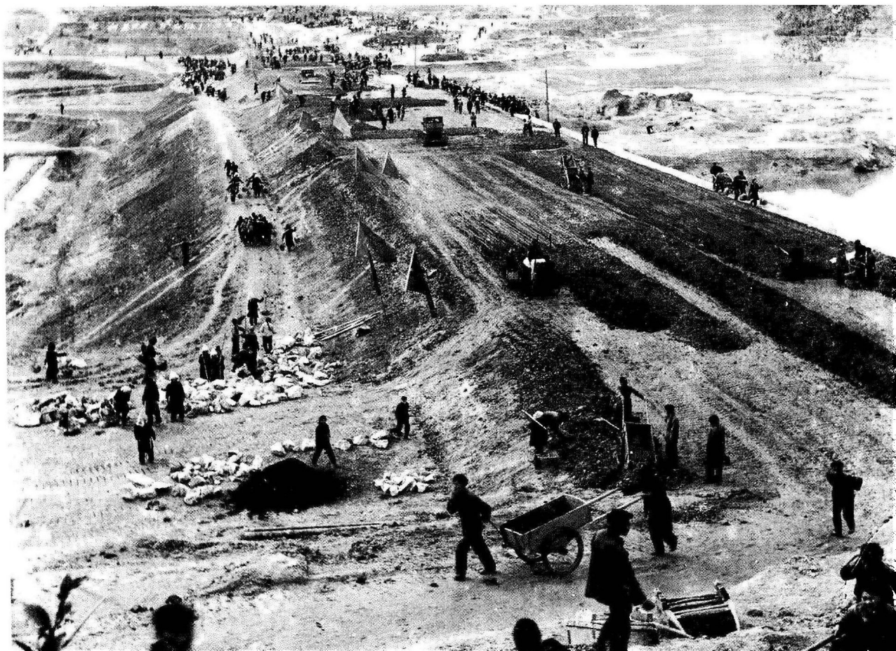
早楼水库土坝续建加固阶段施工现场
