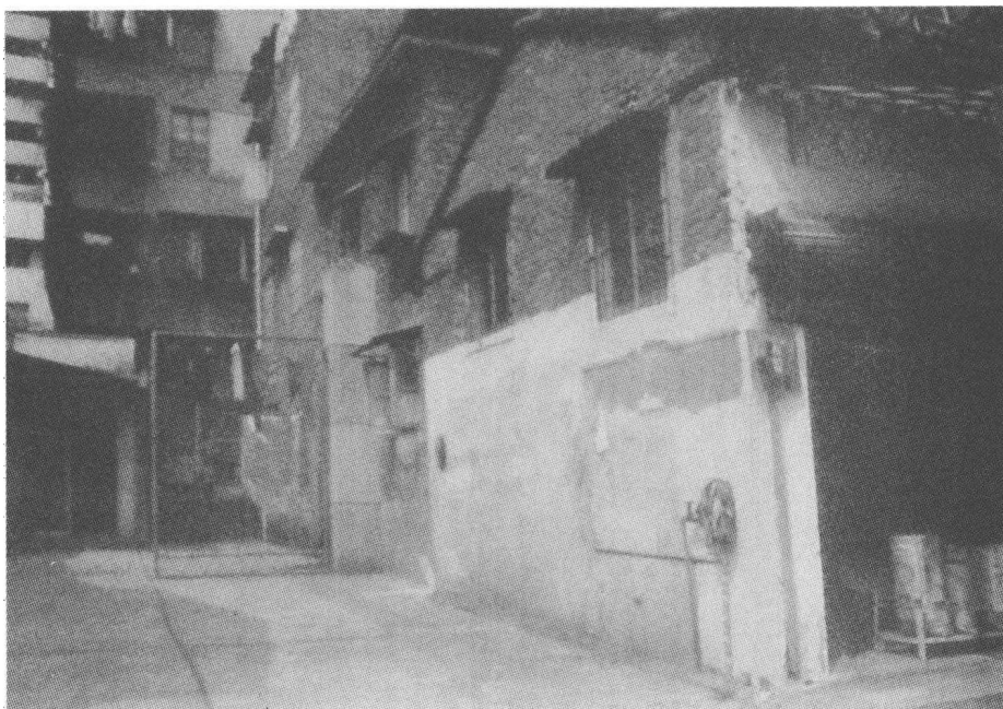
这是 1939 年 1 月中共广东省委召开第四次执委扩大会议的地方，图为会议旧址，位于韶关城区西河黄田坝（武江北路 28 号靠江边处）
