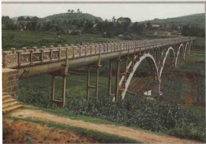
黔西县附廓水库 “U”型薄壳渡槽。
