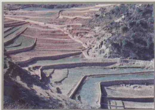
威宁县兴发乡水土 保持坡改梯工程
