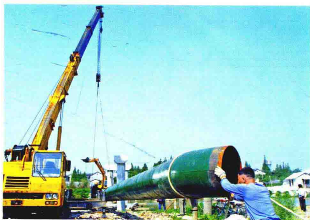
污水纳管工程
