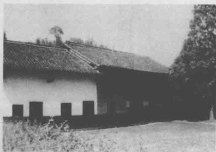
水口叶家祠 毛泽东主持首次连队建党旧址
