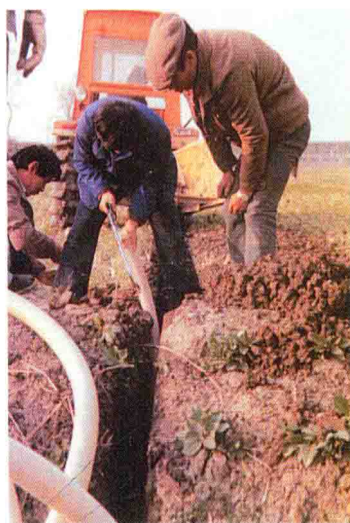
埋设地下暗管
