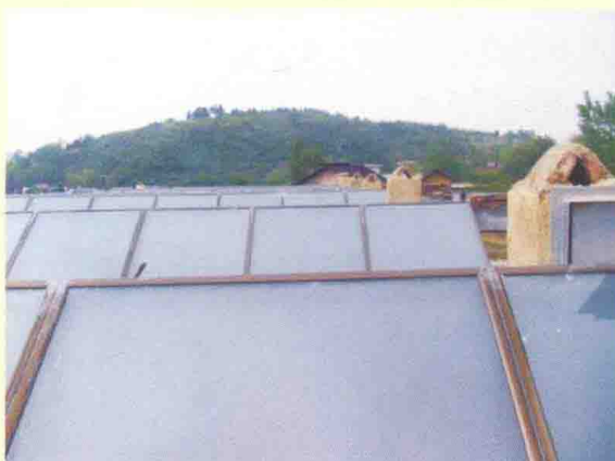
湖南邵阳烟区研制的平板式太阳能密集烤房
