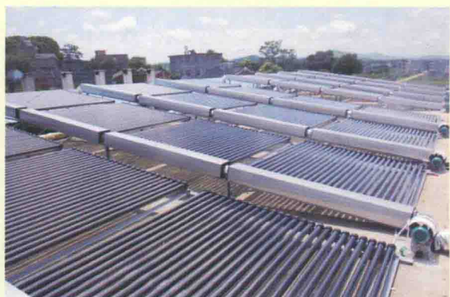
广西贺州烟区研制的真空管式太阳能密集烤房
