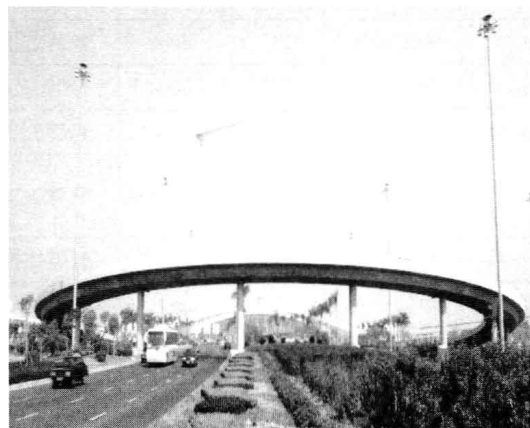
图 1-12 混凝土结构掉头弯桥
