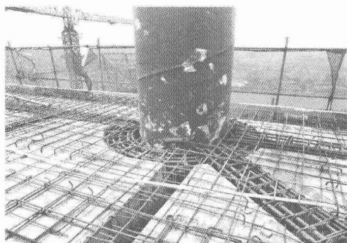
图 1-4 钢管混凝土柱
