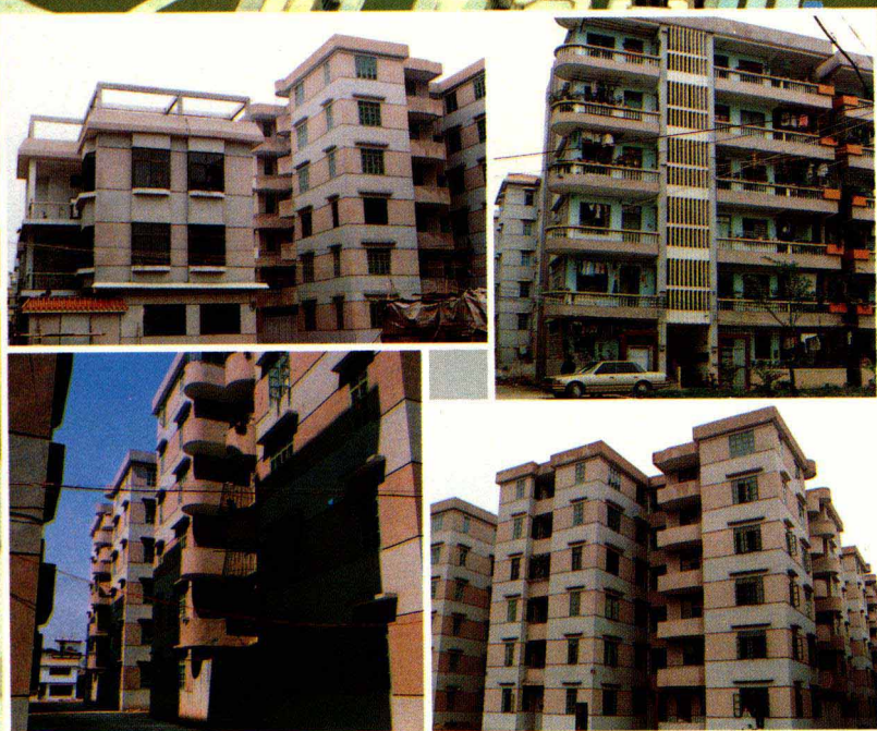
德勝建設總公司設計、施工的商品房
