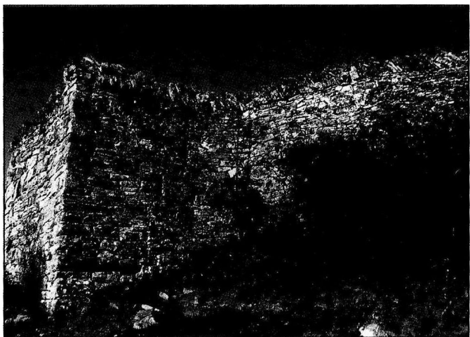
甘塘堡古屯墙
