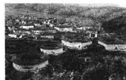
图 1-24 福建 永定县 圆形土楼
