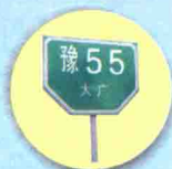
高速公路里程桩 绿底白字，位于高速公路两侧或中间隔离带上
