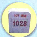
国道里程桩 白底蓝字，位于公路一侧的路基上
