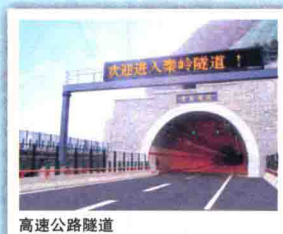
高速公路隧道
