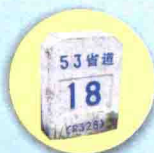
省道里程桩 白底蓝字，位于公路一侧的路基上
