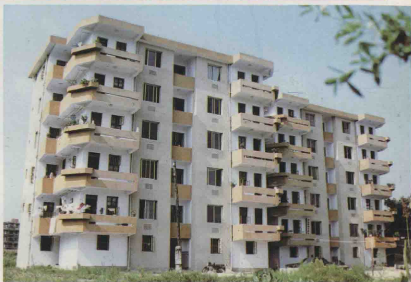
城建职工住宅楼
