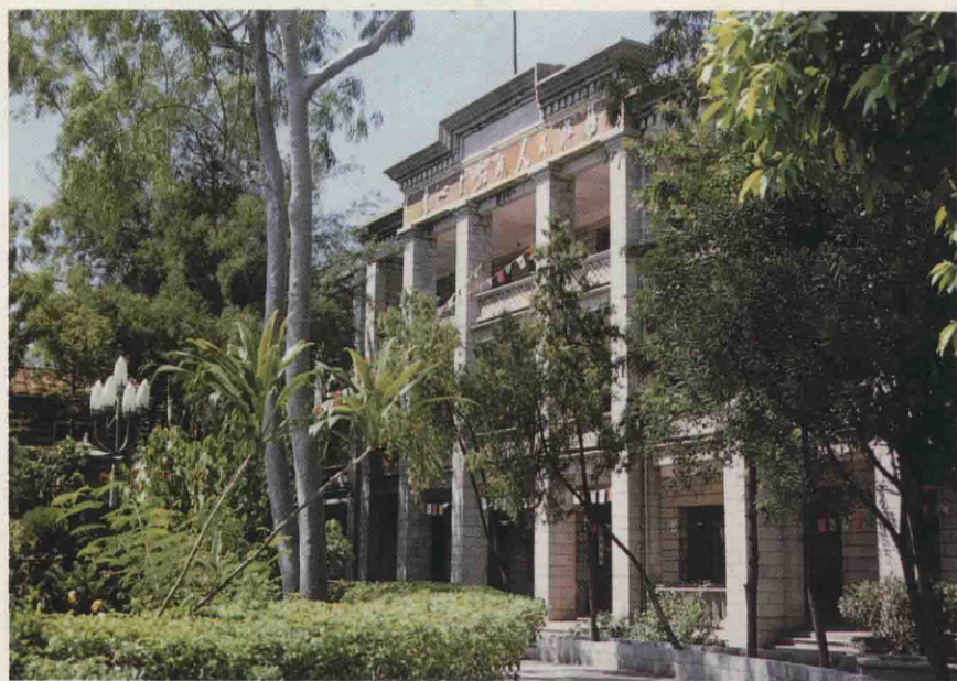
中共惠安县委、纪 委、县政协办公大楼
